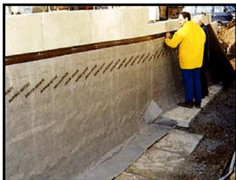
Водоотводящая способность увеличена благодаря оптимальному сочетанию расстояния между округлыми шипами дренажного полотна и их формы.
